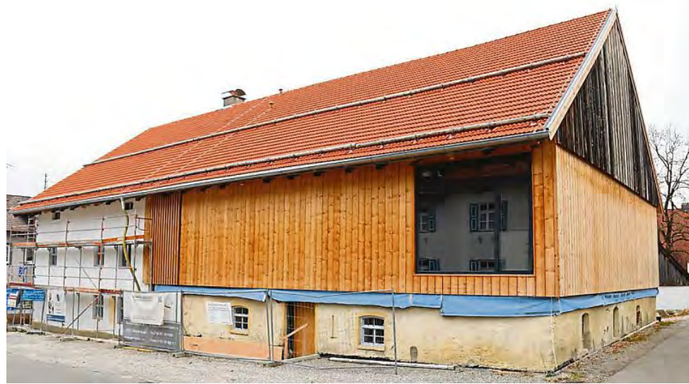
Allmählich schaut ein Ende her bei der Sanierung des Lampl-Anwesens in Bad Kohlgrub. 2019 soll jetzt die Dauer-Baustelle endgültig abgeschlossen sein.
